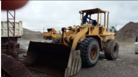
Foto 19. Cargadora frontal para cargar volquetas.
