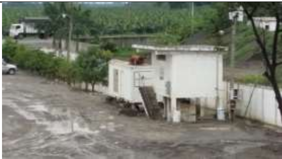
Foto 7. Generador de energía dentro de contenedor para disminuir emisión de ruido.
