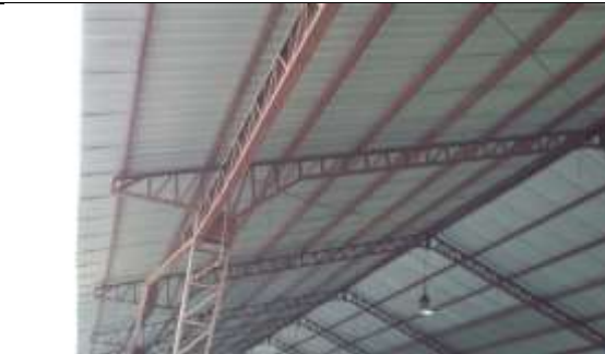
Foto 25. Techado de área de taller.
