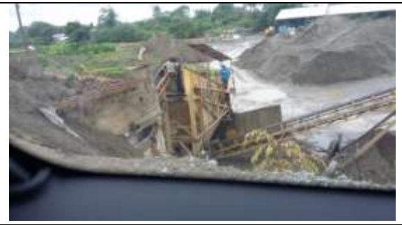
Figura 1 y 2. Tolva de alimentación donde se recibe la arena transportada por los camiones
